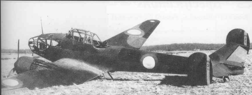
Potez 63.11 n°212 ayant fauché son train gauche en 1940. Notez la double cocarde et le mât d'antenne placé à l'avant de la cabine d'une façon inhabituelle (MAE) This Potez 63.11 broke his port side landing gear in 1940. Note the double wing cocarde and the unusual position of the antenna
