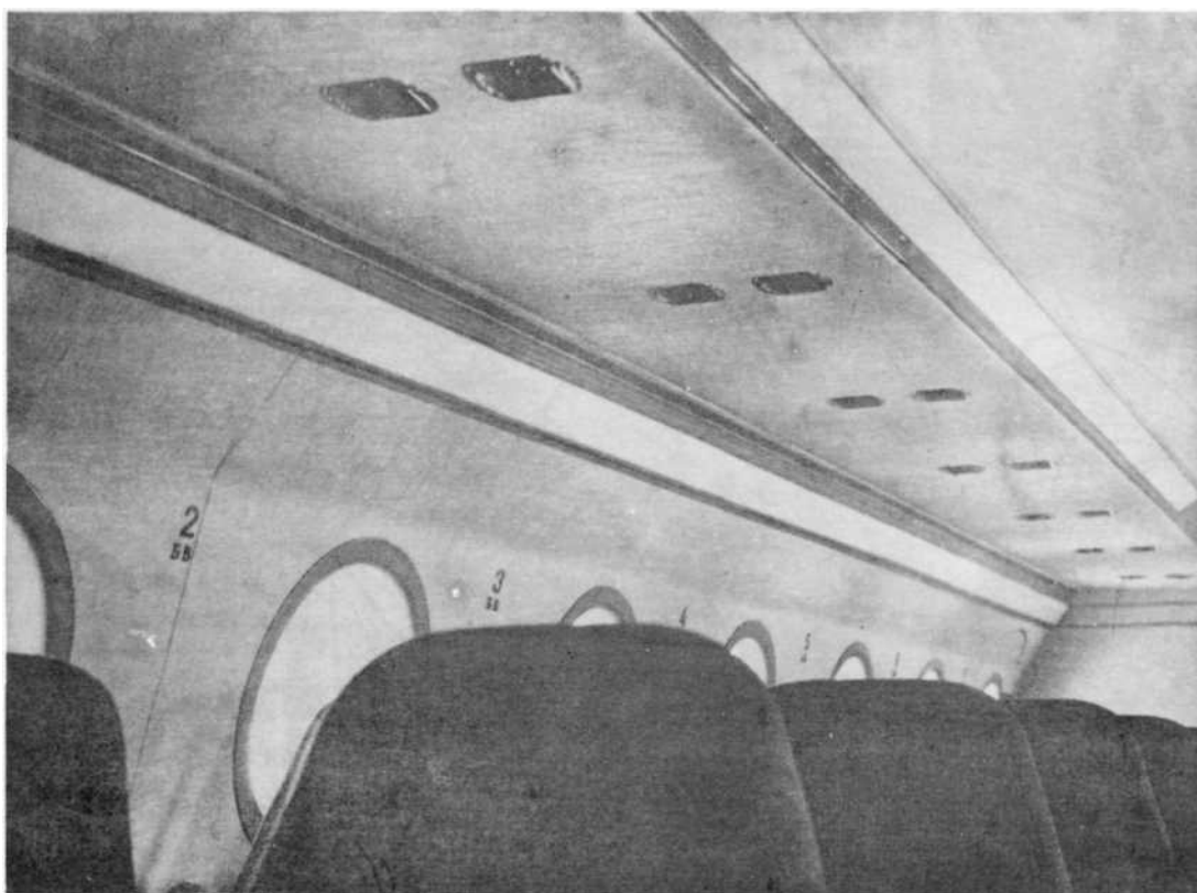
Рис. 1. ШИТКИ ВЕНТИЛЯЦИИ И ПЛАФОН ОСВЕЩЕНИЯ
