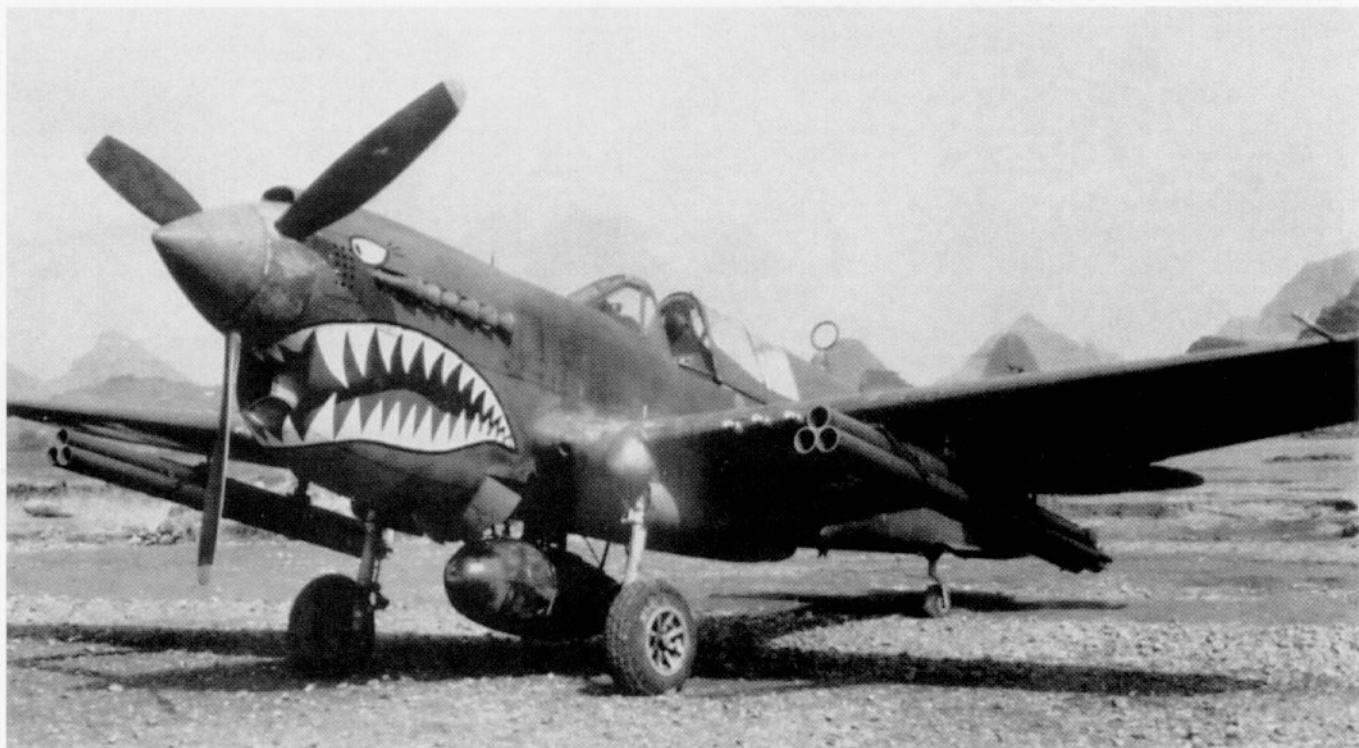
Poniżej: P-40N uzbrojony w wyrzutnie bazook pod skrzydłami, Kweilin, Chiny. Pod kadłubem zbiornik dodatkowy.
