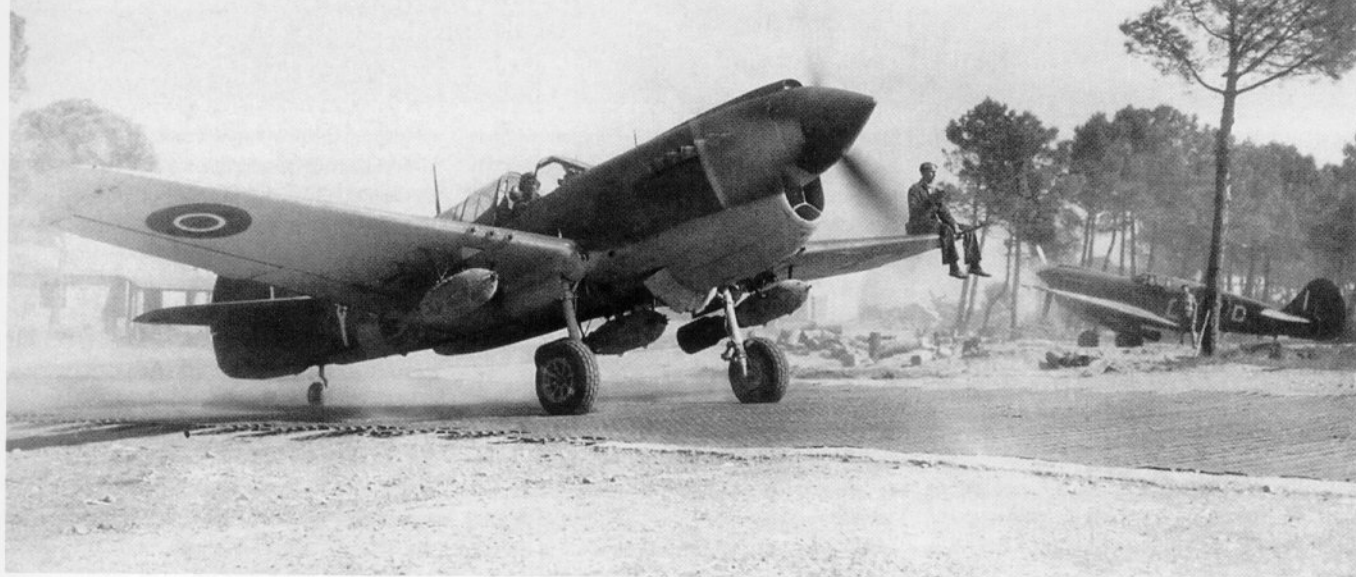
Inny Kittyhawk oznaczony GA○Y ze 112. dywizjonu RAF, już bez namalowanej szczęki, 1944 rok. Pod samolotem widoczne są trzy bomby po 500 funtów.
