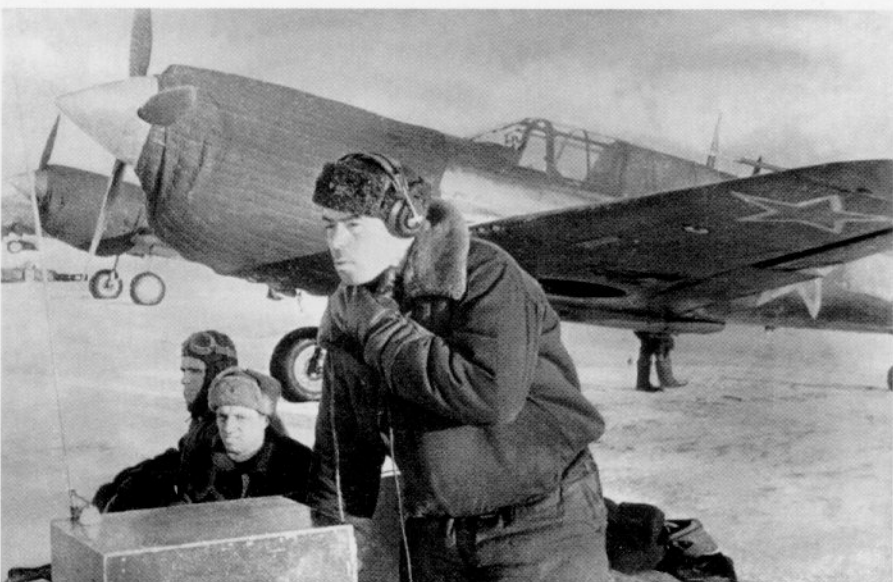
Poniżej: P-40 lotnictwa Floty Północnej na lotnisku zimą 1943/44 roku. Widoczne są specjalne „ubranka“ zapobiegające przehłodzeniu silnika.
